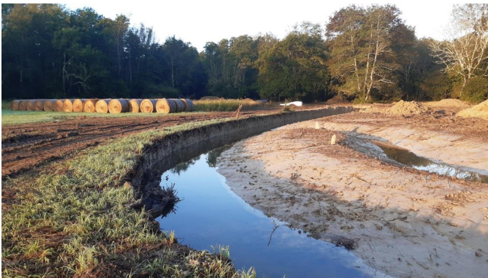
Premier méandre avant la confluence avec le Séran : les rouleaux de blache ont été faits par l'EARL La Grange des Prés et seront utilisés pour couvrir le sol à nu au bord des méandres.
